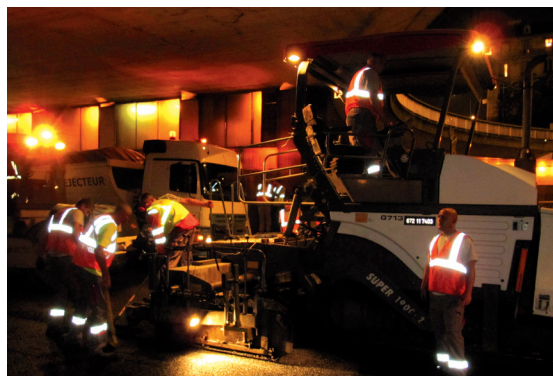
Travaux de mise en place d'un revêtement anti-bruit
